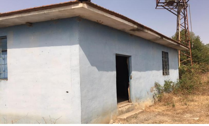
İnebeyli Taşağıl Pompa Görüntüsü
